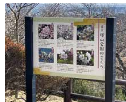
施工後：神奈川県立塚山公園・表示面作成（神奈川県横須賀市）
